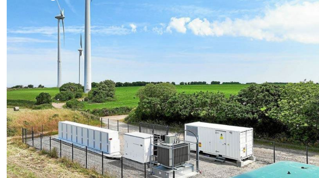
Stockage de PLOUGUIN 3 MW/3,35 MWh
